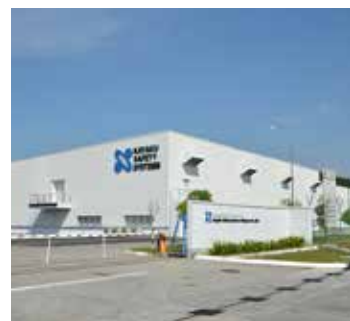
Kayaku Safety Systems / Malaysia Lắp đặt năm 2022
