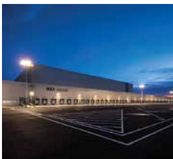
Kho Ikea / Malaysia Lắp đặt năm 2020
